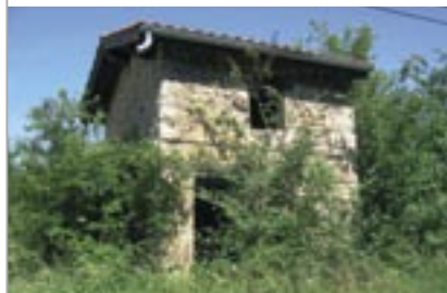
Une loge à proximité de la route de Brasseronde.
